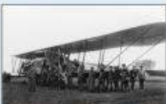
Корпусный аэродром в Петербурге утро 16 июня 1914 года
