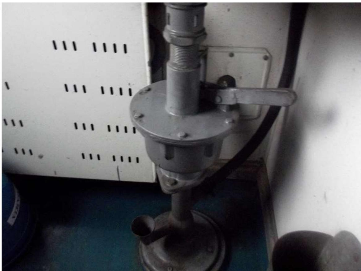
Воронка для оттаивания переливного трубопровода расположена под кипятильником.
