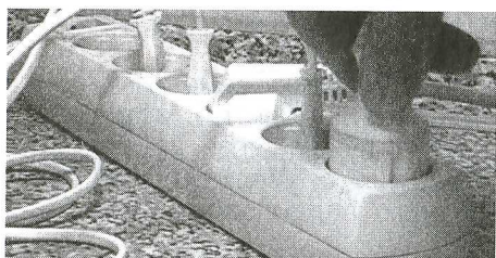
Пять электроприборов подсоединены к удлинителю. Существует опасность перегрузки электросети
