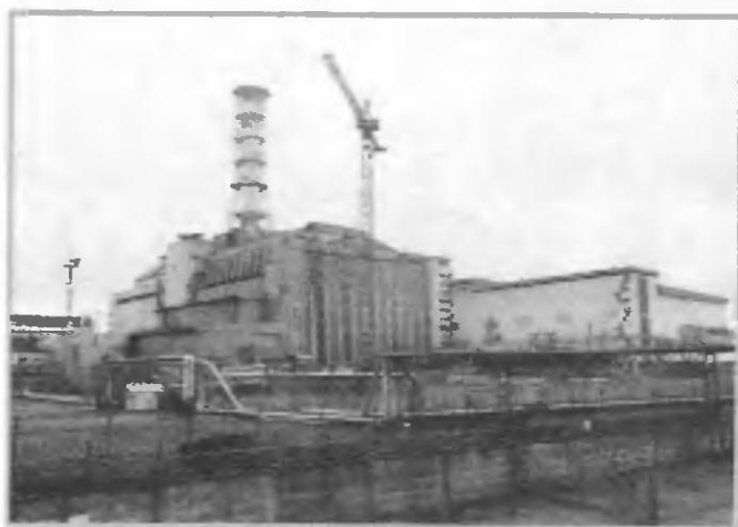
Саркофаг над четвертым энергоблоком Чернобыльской АЭС. 26 апреля 1986 г. здесь произошла самая крупная авария за всю историю атомной энергетики
