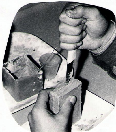
8. Разъединение полуформ.
